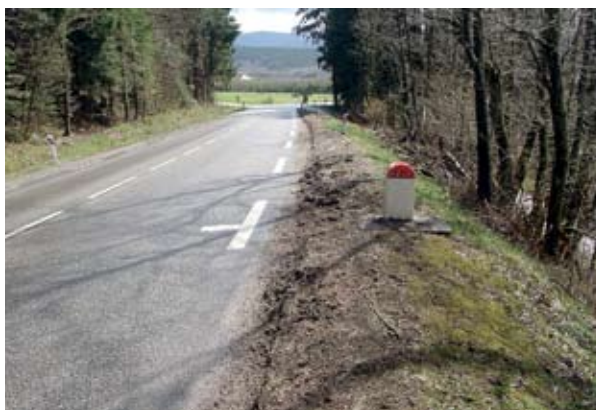
Source : CETE de l'Est
