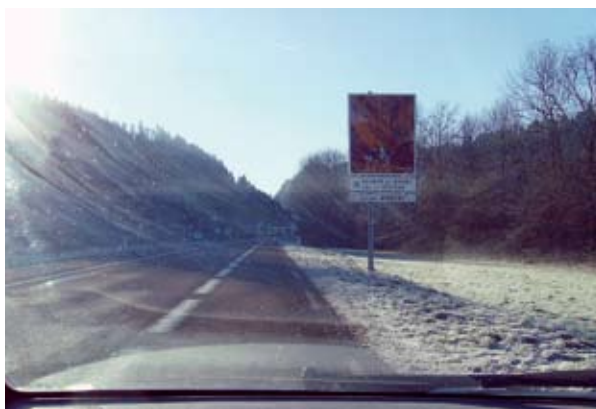
Source : CETE de l'Est
