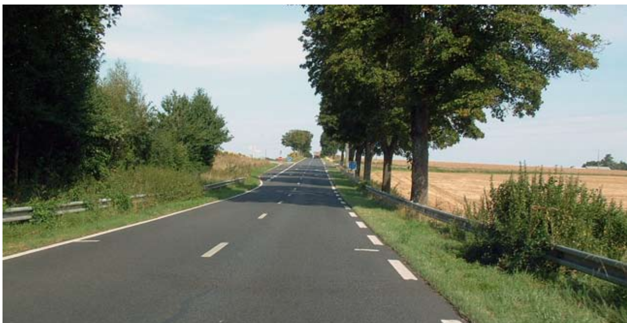
Source : CETE de l'Est
