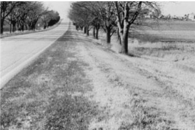
Figure 91 : Pente de 1V :3H (Source : HSM)
