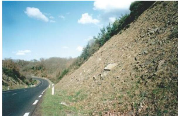
Figure 46 : Talus de déblai constituant un obstacle non isolé (Source : Cerema)
