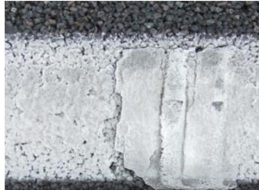
Figure 73 : DAS en protubérance (source : IFSTTAR)
