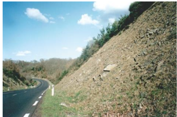
Figure 46 : Talus de déblai constituant un obstacle non isolé (Source : Cerema)
