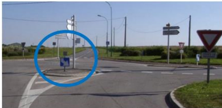
Figure 95 : Ilot séparateur en carrefour (Source : Cerema)
