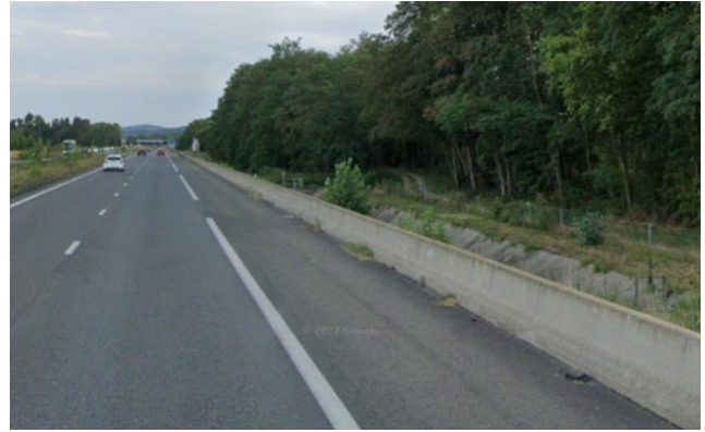
Figure 44 : Glissière béton (Source : Google Maps)
