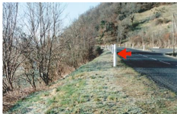
Figure 48 : Talus de remblai avec dénivelé important, constituant un obstacle non isolé, l'emploi de balises J1 n'étant pas approprié (Source : Cerema)
