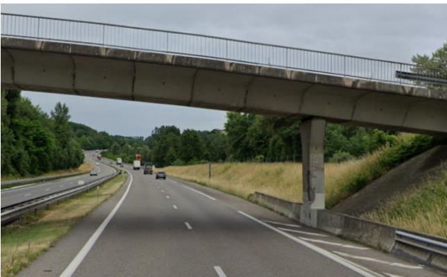
Figure 53 : Pile de pont correctement isolée (GBA dans la continuité de la pile) ne constituant pas un obstacle (Source : Google Maps)
