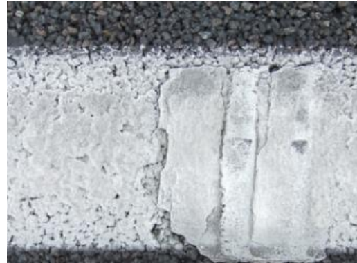
Figure 73 : DAS en protubérance (source : IFSTTAR)
