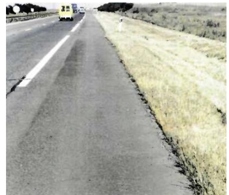
Figure 70 : ZR revêtue (Source : Cerema)
