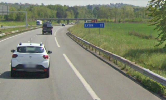
Figure 43 : Glissière métallique (Source : Google Maps)
