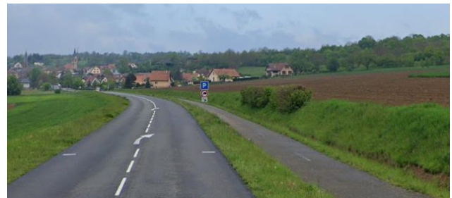
Figure 59 : Chemin piétonnier bitumé séparé traduisant un trafic piéton en cheminement (Source : Google Maps)
