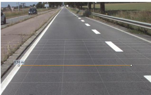
Figure 36 : Cas d'un dispositif d'entrée (Source : IREVE)
