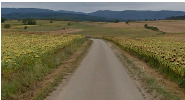
Figure 87 : Marquages d'axe et de rive manquants (Source : Google Maps)
