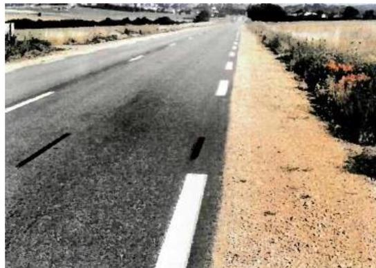
Figure 67 : ZR stabilisée (Source : Cerema)
