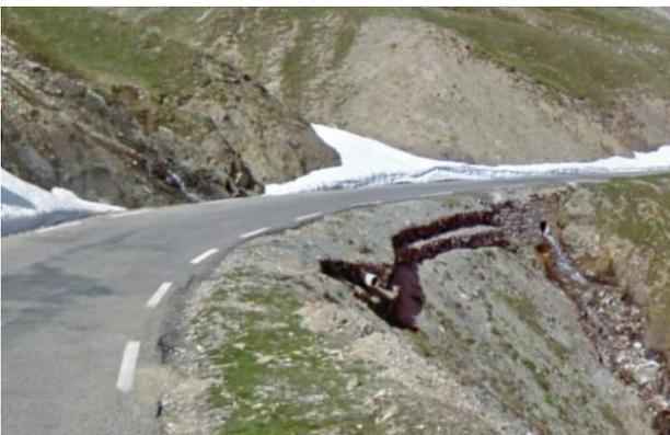
Figure 45 : Talus de remblai constituant un obstacle non isolé (Source : Google Maps)
