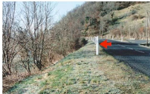
Figure 46 : Talus de remblai avec dénivelé important, constituant un obstacle non isolé, l'emploi de balises J1 n'étant pas approprié (Source : Cerema)
