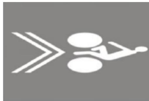
Figure 59 : Exemple d'indice faisant croire à un cheminement cycle : double chevron avec figurine vélo (source : IISR)
