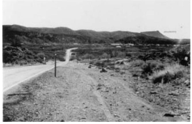
Figure 88 : Pente de 1V :4H (Source : HSM)
