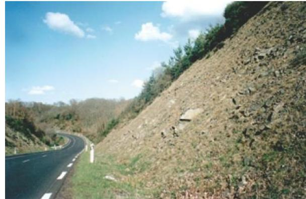
Figure 44 : Talus de déblai constituant un obstacle non isolé (Source : Cerema)
